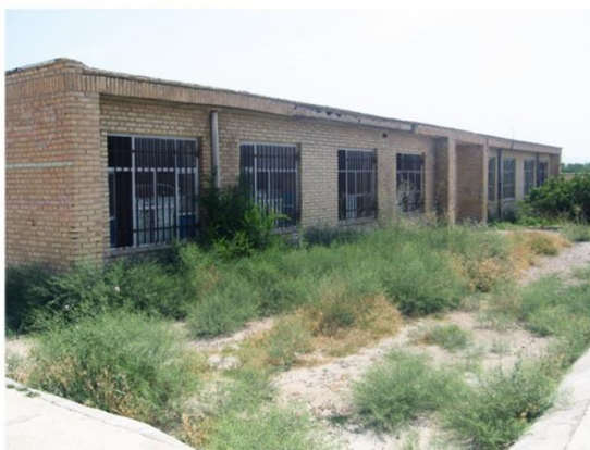
▲ ۵. ساختمان قدیم مدرسه
