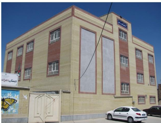
۱. جبهه جنوب شرقی حجم ساختمان
