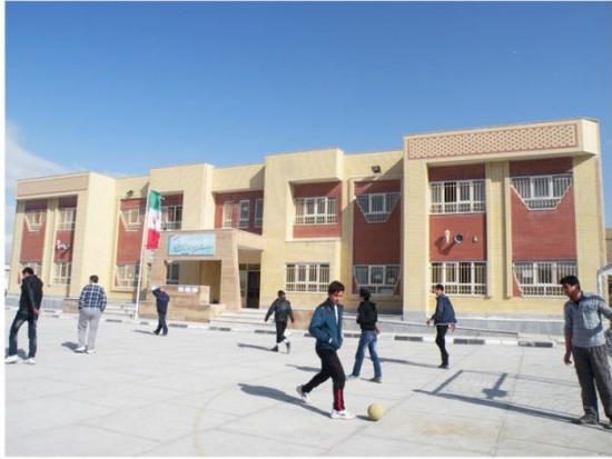
▲ ۱. نمای اصلی (ورودی) ساختمان
