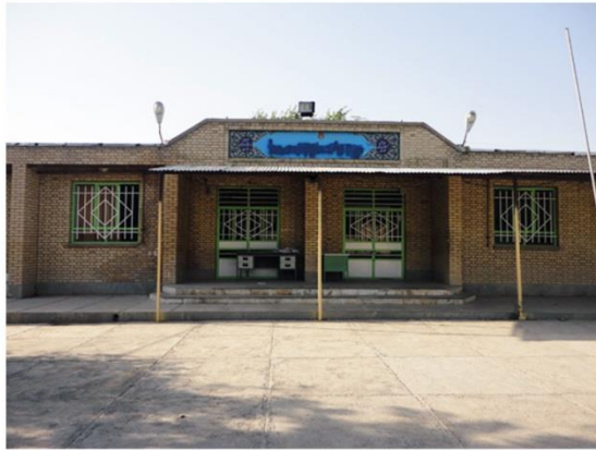
▲ ۱. نمای اصلی (ورودی) ساختمان
