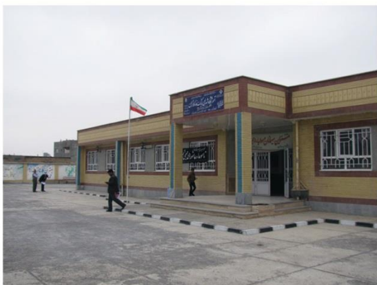
▲ ۲. جبهه اصلی (ورودی) ساختمان
