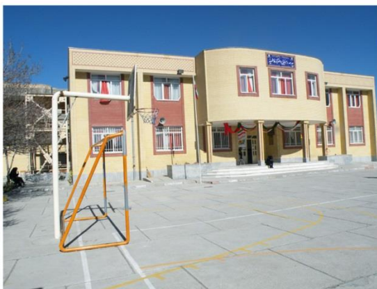
۱. نمای اصلی (ورودی) ساختمان
