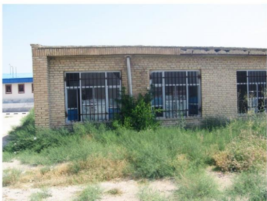
▲ ۶. ساختمان قدیم مدرسه
