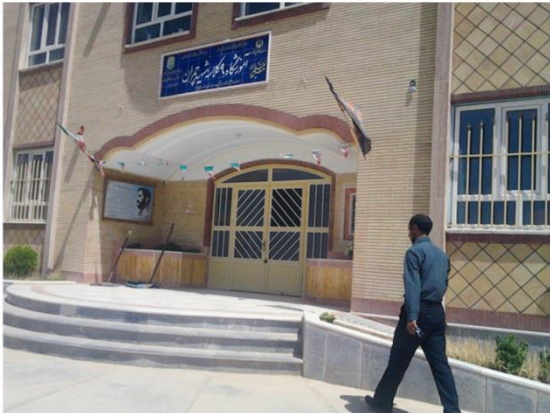
۲. جبهه اصلی (ورودی) ساختمان مدرسه
