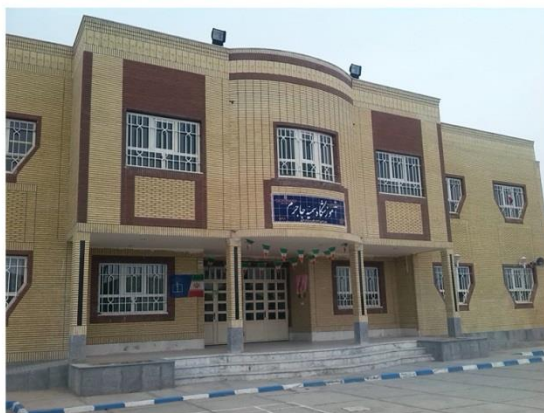
▲ ۱. نمای اصلی (ورودی) ساختمان
