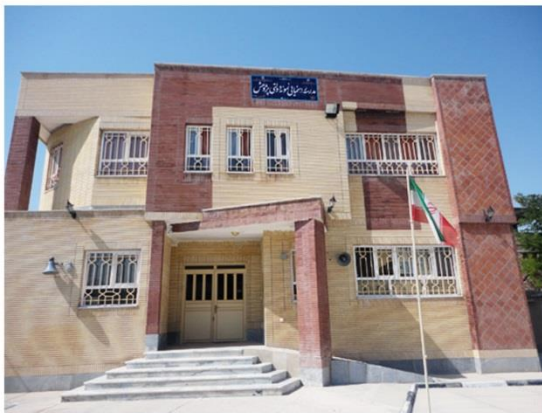
۱. نمای اصلی (ورودی) ساختمان
