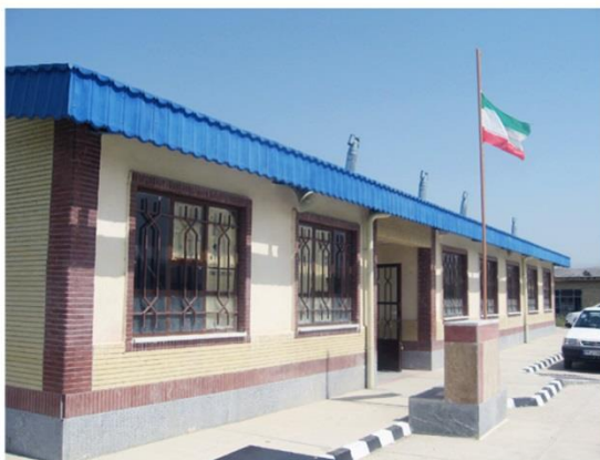
▲ ۱. نمای اصلی (ورودی) ساختمان
