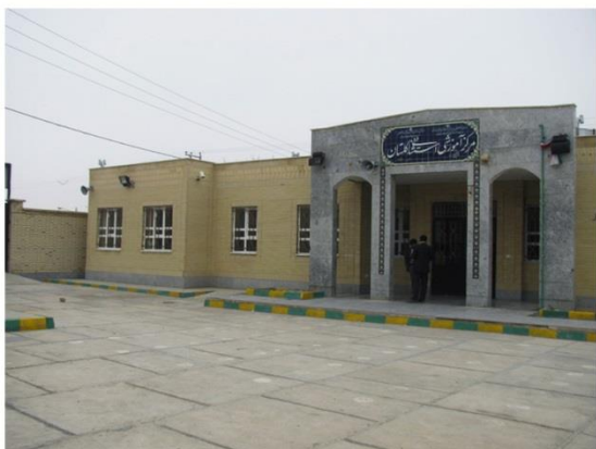
▲ ۲. نمای اصلی (ورودی) ساختمان
