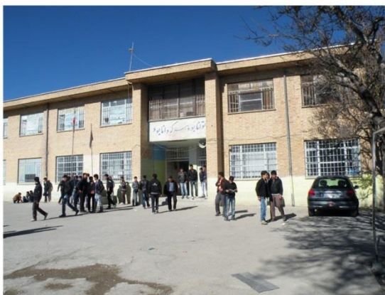
۱. نمای اصلی (ورودی) ساختمان
