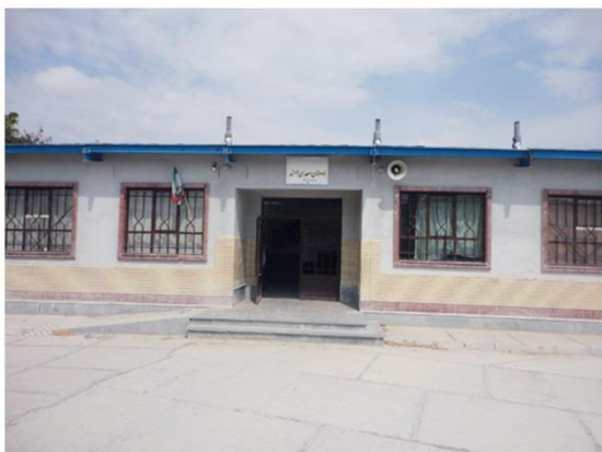
▲ ۲. نمای اصلی (ورودی) ساختمان
