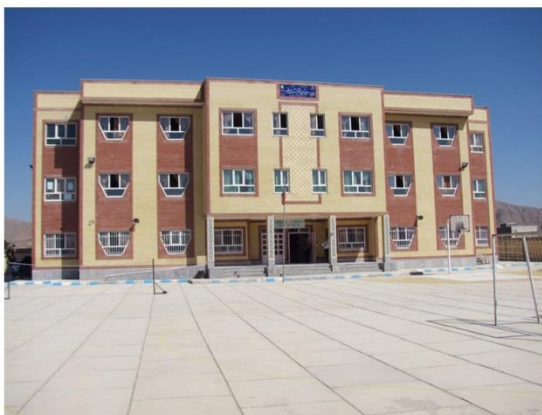
▲ ۱. جبهه اصلی (ورودی) ساختمان مدرسه
